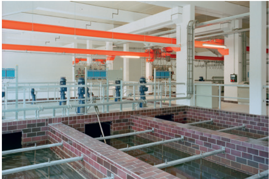
Abb. 1: Im Wasserwerk Carlsfeld wurde eine zusätzliche Sedimentationsstufe eingebaut, um den steigenden DOC-Konzentrationen Herr zu werden.
