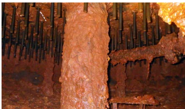
Filtratraminspektion eines Filters
