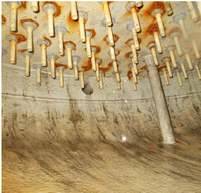
Stahlfilterkessel vor und nach Sanierung und Ergänzung eines Spülluftverteilsystems
