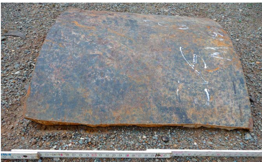
Abb. 2: Die Materialuntersuchung an einem schadens auffälligen Abschnitt aus Grauguss (DN 900, BJ 1908) zeigte werkseitige geringere Wanddicken, welche nicht der damaligen Norm entsprachen. Ergebnis: Trotz nahezu ungeschwächtem Rohrquerschnitt (kein Korrosionsangriff) herrscht eine erhöhte Bruchgefahr auch bei regulären Belastungen
