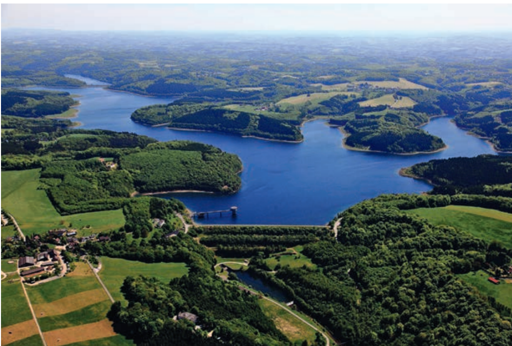
Abb. 3: Luftaufnahme der Großen Dhünntalsperre
