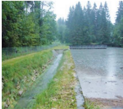
Abb. 5.5: Überschlag des Regenwasserüberlaufbeckens (Mischkanalisation) nach einem Starkregenereignis
