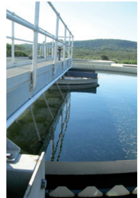
Abb. 4.5: Nachklärbecken in der konventionellen Abwasserreinigung
