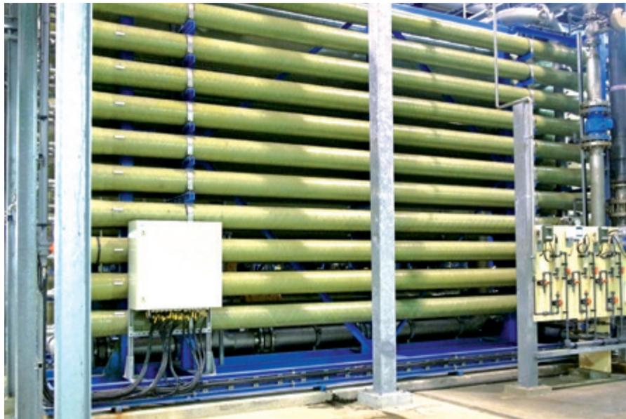
Abb. 4.3: Ultrafiltrationsmembranen zur Aufbereitung von Oberflächenwasser
