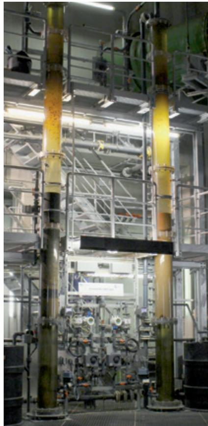
Abb. 5.3: Technische Barrieren der Trinkwasseraufbereitung: Pilot-Schnellfilter in der Oberflächenwasser-Aufbereitung Berlin-Tegel, Verbundprojekt ASKURIS
