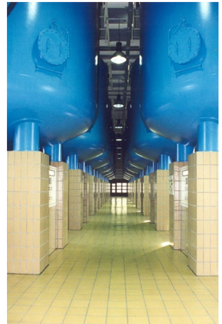
Filterhalle des Wasserwerks Mülheim-Styrum/West
