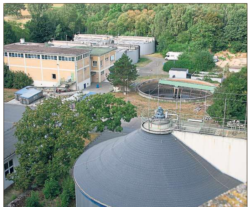
Blick vom Faultrum: Der Fachbereich Tiefbau möchte eine vierte Reinigungsstufe gegen Mikroschadstoffe bauen. Bild: Bojak
